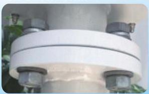
7. Instale el aerogenerador haciendo coincidir la brida del aero con la brida de la torre; utilice los accesorios provistos tuercas/arandelas y apriete las tuercas firmemente.
