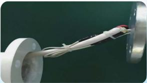
6, conecte tres cables de la turbina eólica al cable de transmisión, cada longitud del cable empalmado es de al menos 30mm; sujete los cables con cinta, su longitud es de aproximadamente 100mm. (hágalo como muestra la imagen de arriba)
